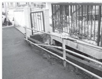
手すりの再整備
