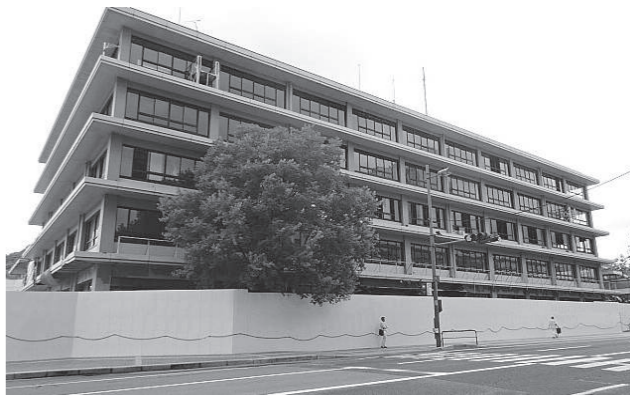
解体が行われている「旧市庁舎」
