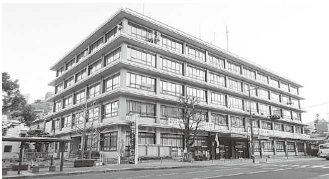
建設予定地の現市庁舎
