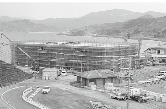
建設が進む「のもぎき恐竜博物館」
