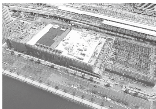
11月開業予定で建設中の「出島メッセ長崎」
