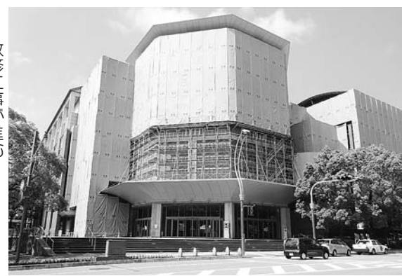
改修工事が進む長崎ブリックホール
