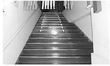
【舞台上がる階段】 出演者が舞台袖に上がるためには、階段を利用するしか経路がない。施設自体にエレベーターやエスカレーターが設置されておらず、バリアフリーに対応していない。
