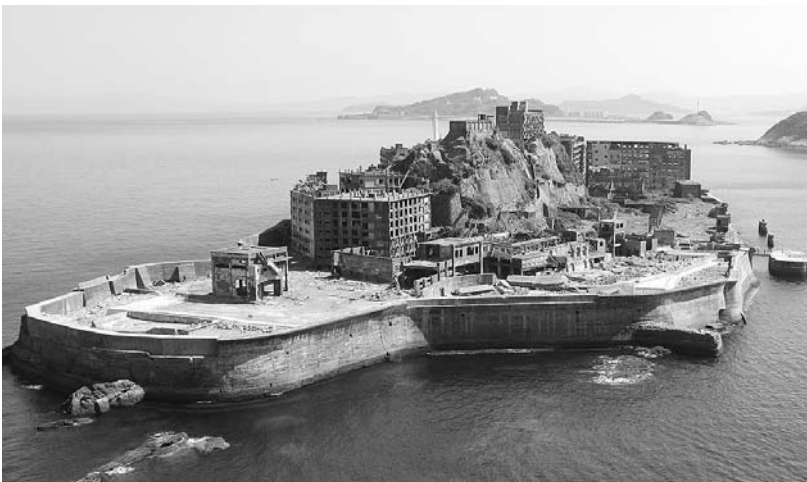
見学施設の点検や修繕が行われている端島炭坑(軍艦島)
