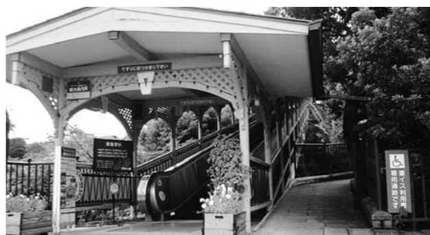
老朽化した「動く歩道」
