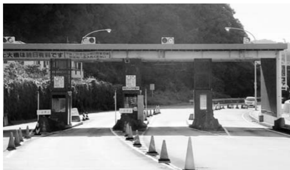
矢上大橋料金徴収ゲート
